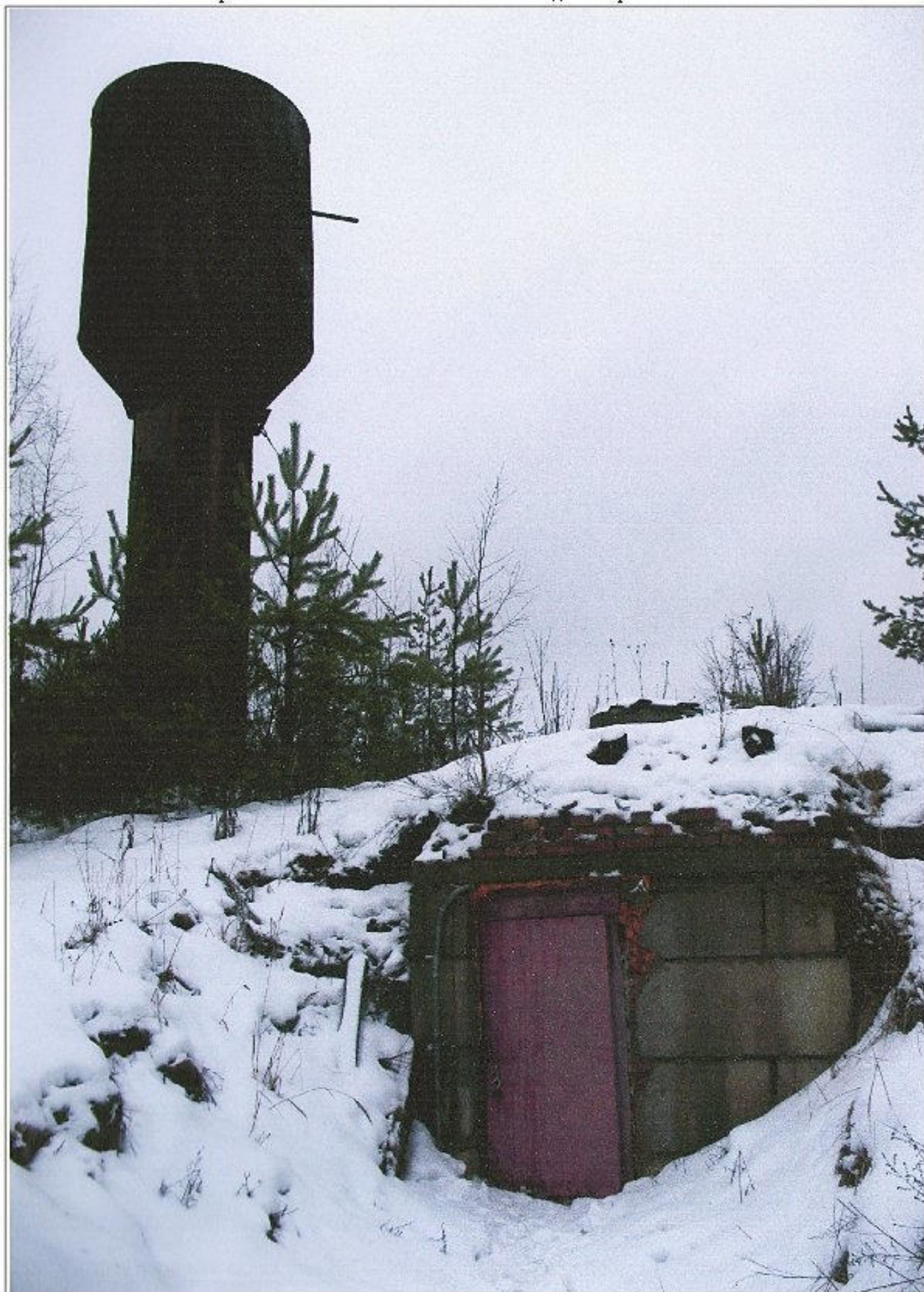
Артезианская скважина №36911 и водонапорная башня
