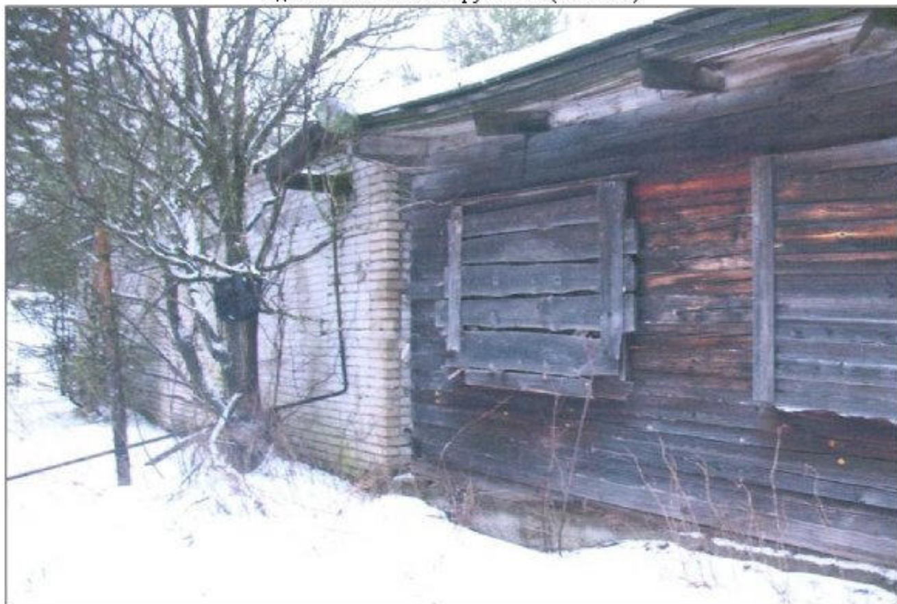
Здание очистных сооружений (п. Янега)
