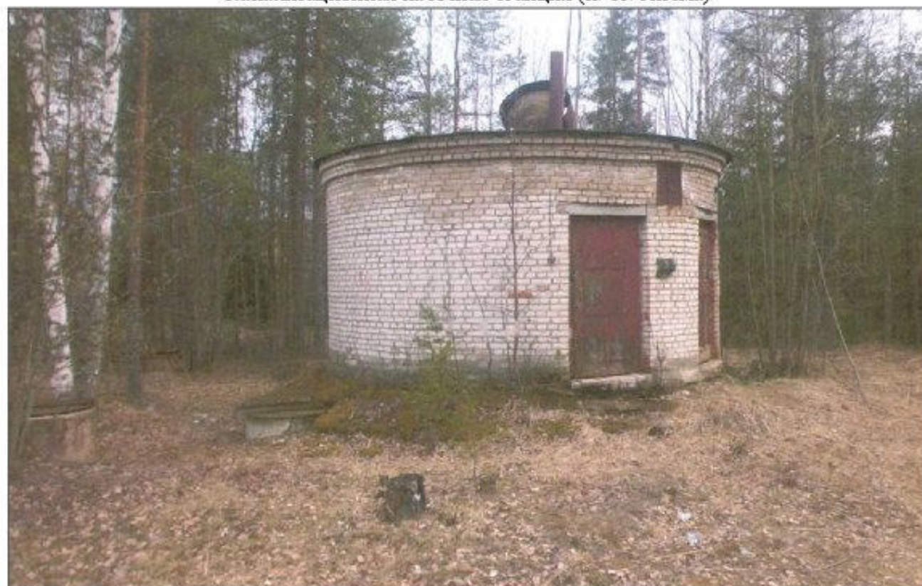
Канализационная насосная станция (п. ст. Инема)
